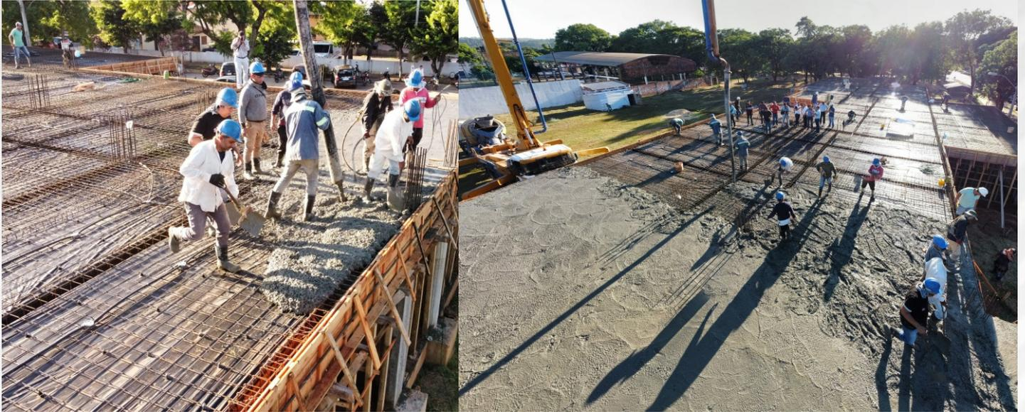
La Arq. Cynthia Montiel, responsable de la obra, manifestó que a mitad del año 2024 la estructura de la primera planta del edificio llegaría a su etapa final. A finales del año 2023 se inició la armadura negativa y positivo de la losa y a inicio de este año el vertido de hormigón masa de las vigas y losa.
